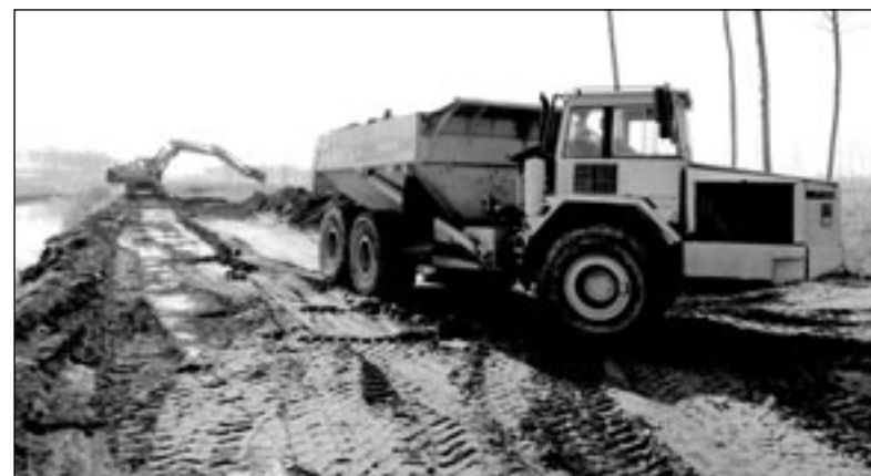
Un intervento di bonifica e consolidamento sul fiume Tartaro
