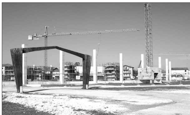
Centro risi: i lavori in fase di avanzamento
