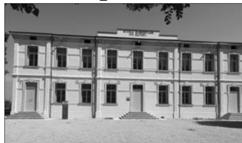
La nuova sede del municipio nelle ex scuole elementari
