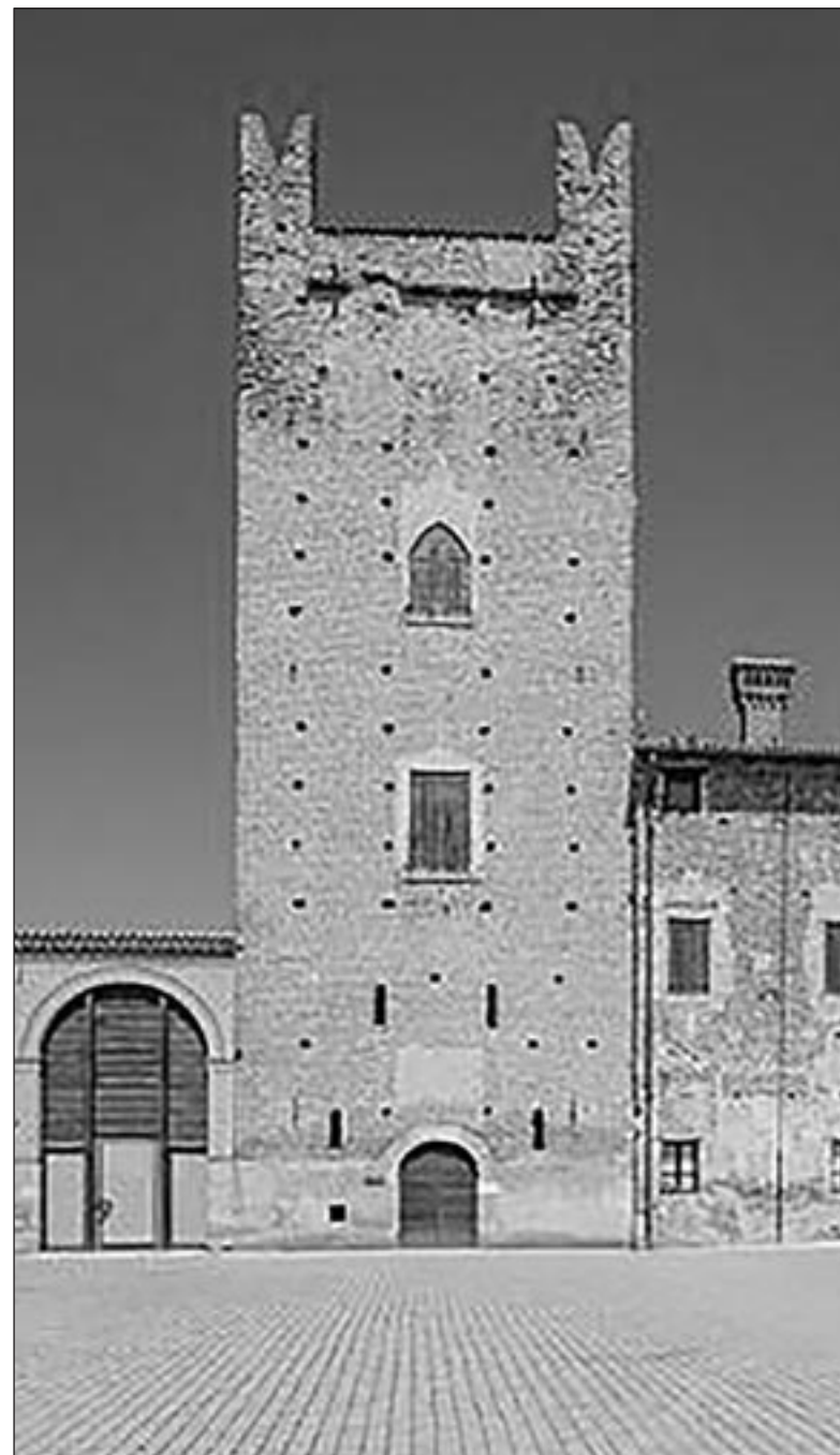
Castello di Salizzole, la torre ovest
