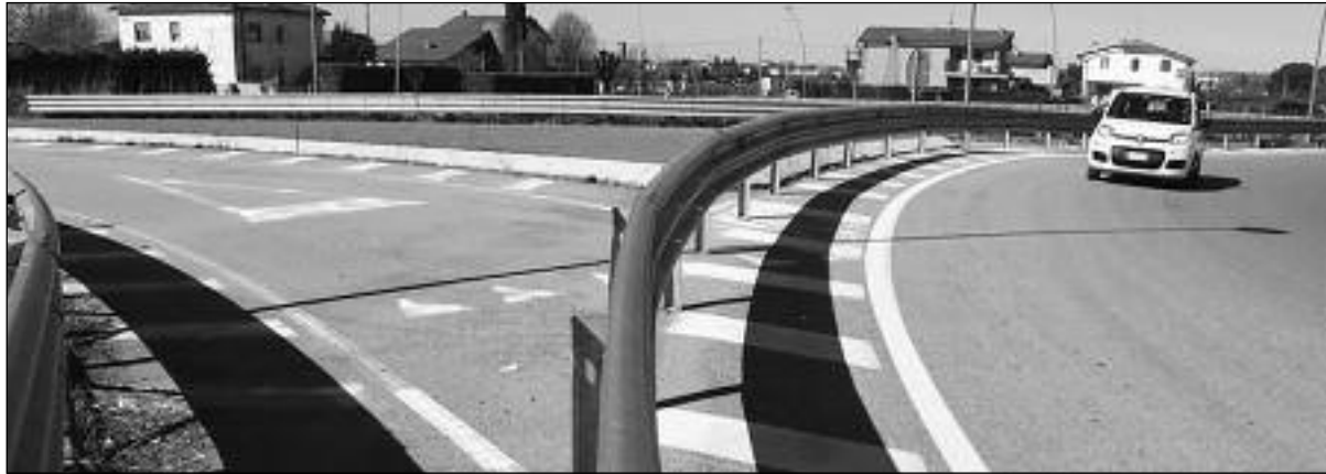
L'imbocco del primo tratto dell'incompiuta "Grezzanella" nel territorio di Villafranca
